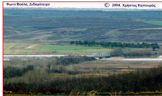
Εικ. III, Η σιδηροδρομική γέφυρα στον Έβρο,
